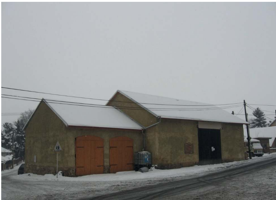
Bývalá pivovarská lednice.
