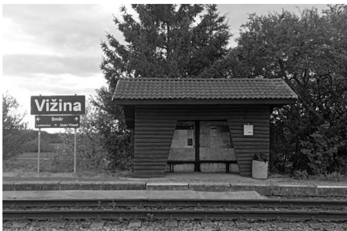
Zastávka Vižina byla zřízena v polovině 30. let. Na fotografii je stavba ze začátku 21. století.
