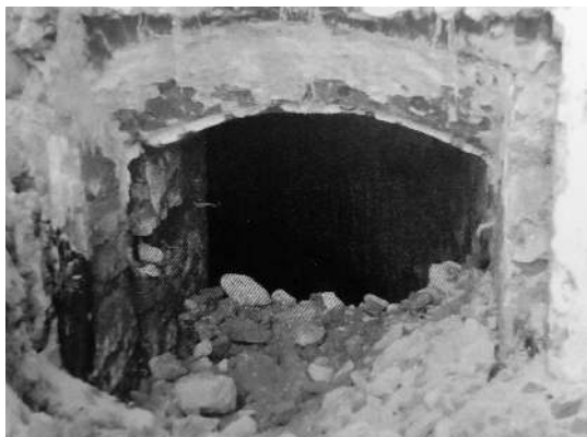
Vchod do podzemní chodby bývalého osovského pivovaru.
