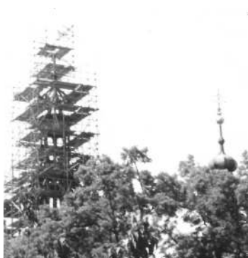
Lešení kolem velké věže osovského kostela při opravách.
