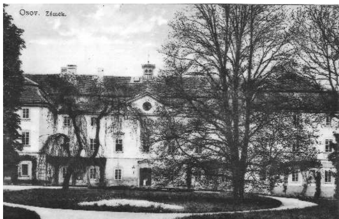
Historická pohlednice východní část zámku osovského.
