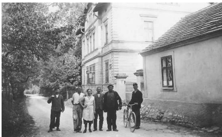
Hostinec "Na poště", později sídlo Místního národního výboru Osov.
