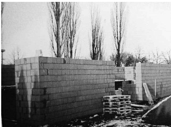
Výstavba nové budovy obecního úřadu před základní školou.
