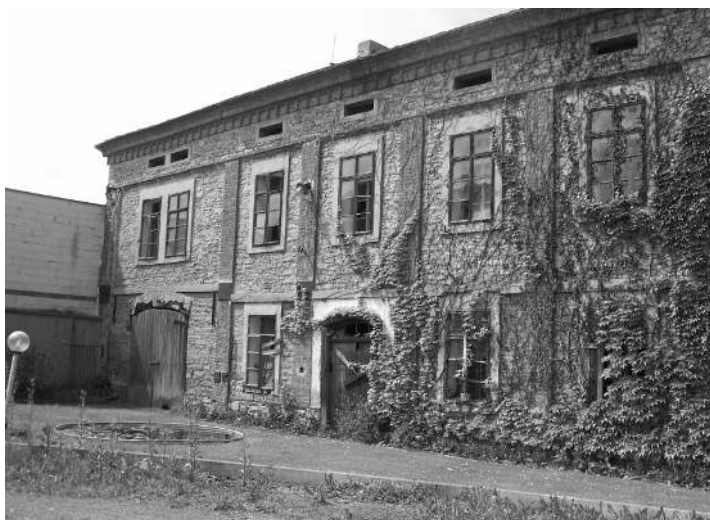
Průčelí administrativní budovy osovského cukrovaru z poloviny 19. století.
